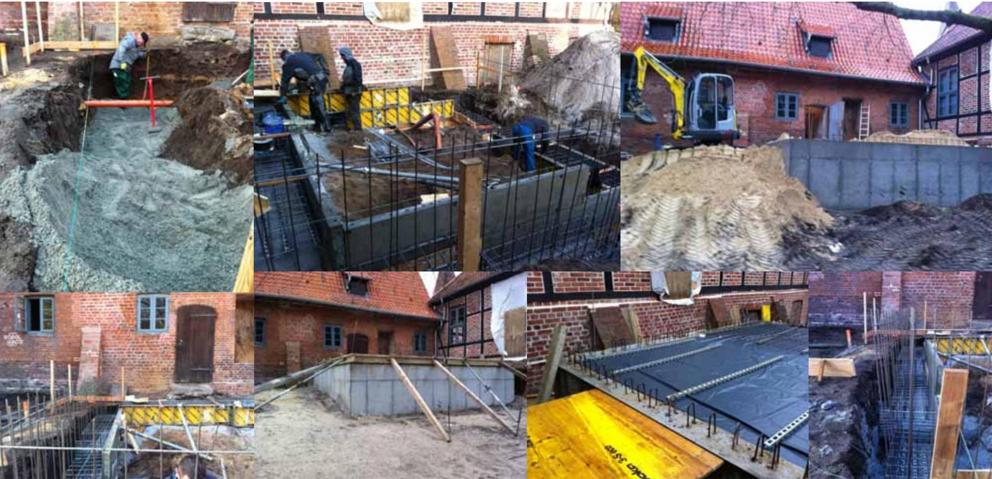
Stahlbetonarbeiten für die Errichtung des Verbinderbaus
