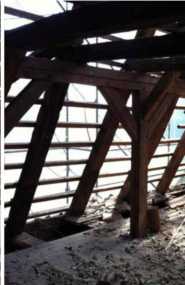
Zimmermannmäßige Instandsetzung der historischen Dachkonstruktion
