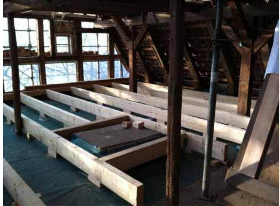
Neue Deckenaufdoppelung im Alten Männerhaus, als Vorbereitung für die Herstellung einer Wärmedämmebene sowie für den technischen Ausbau
