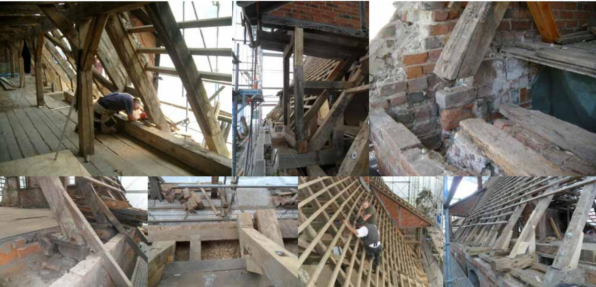
Zimmermannmäßige Instandsetzung der historischen Dachkonstruktion
