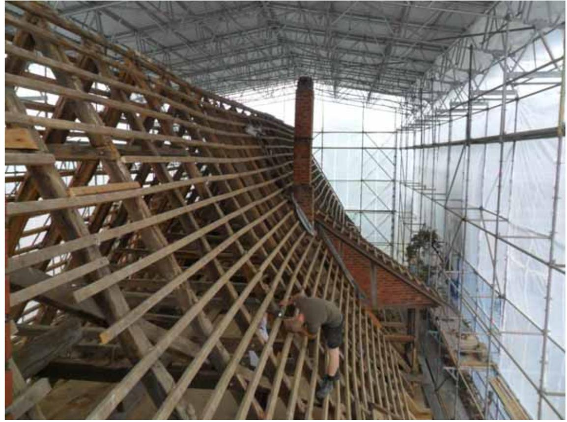
Zimmermannmäßige Instandsetzung der historischen Dachkonstruktion
