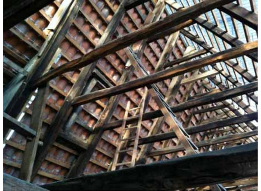
Zimmermannmäßige Instandsetzung der historischen Dachkonstruktion
