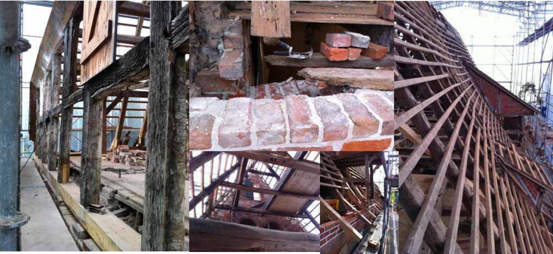
Zimmermannmäßige Instandsetzung der historischen Dachkonstruktion
