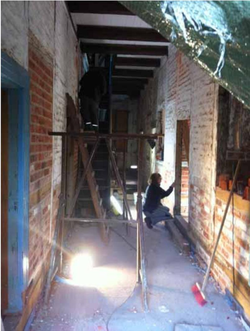
Mittelflur des Neuen Männerhauses mit neu hergestellten Gefachhausmauerungen nach Abschluss der Fachwerkinstandsetzung
