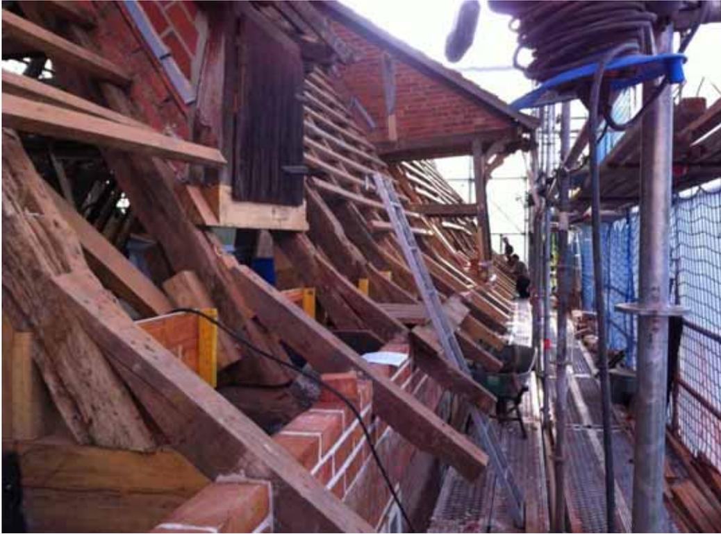
Zimmermannmäßige Instandsetzung der historischen Dachkonstruktion
