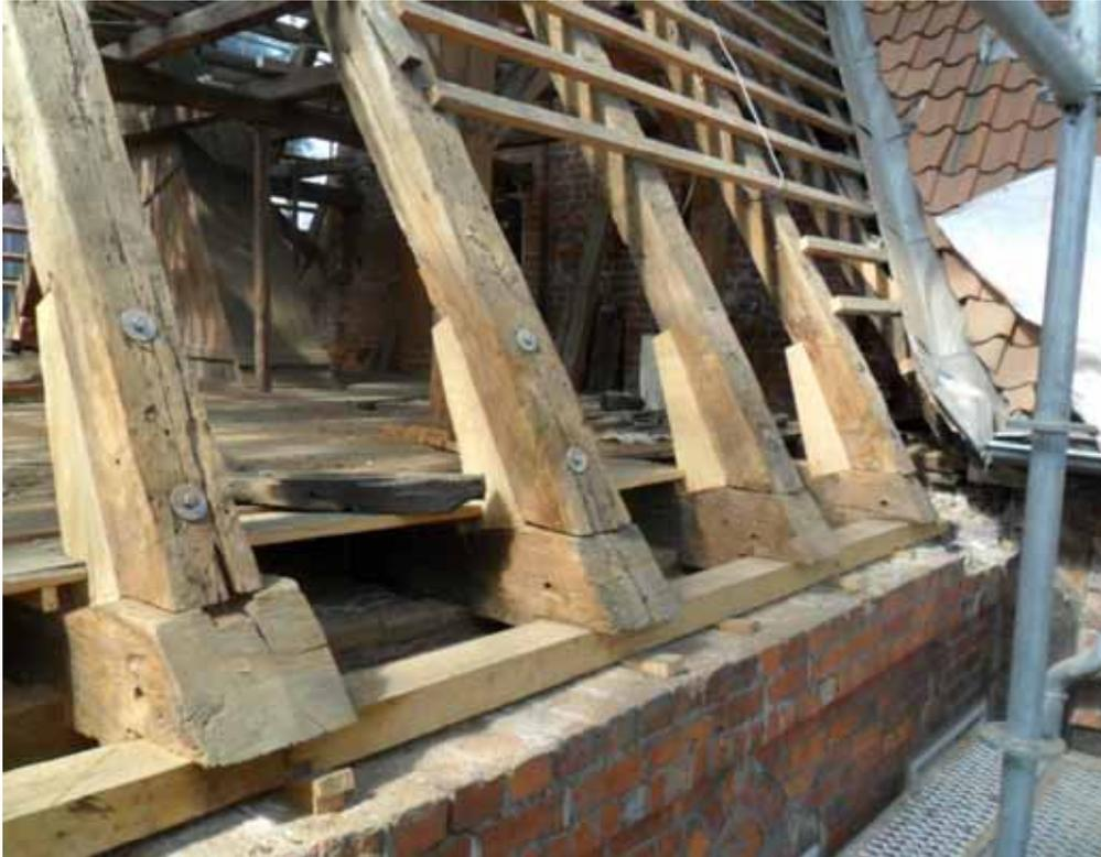
Zimmermannmäßige Instandsetzung der historischen Dachkonstruktion
