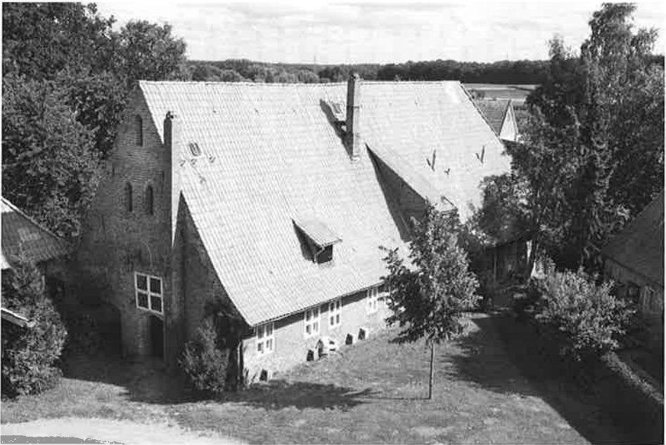
5 Altes Männerhaus, errichtet 1316 (d) Foto Roland Wiczorek, Lehrstuhl Baugeschichte, Universität Cottbus
